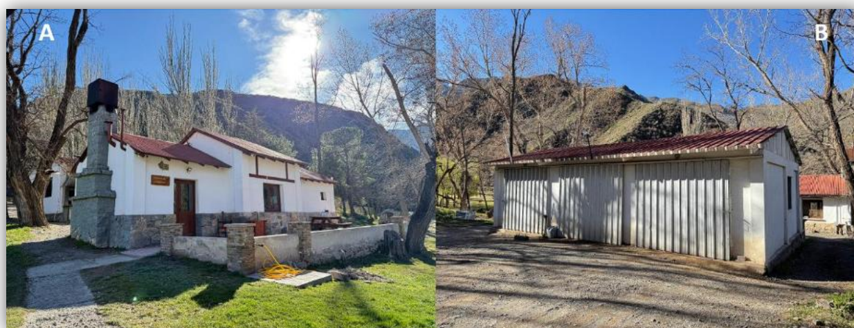
Figura 14: Seccional de Vaquerías (A) y sala de taller (B)
